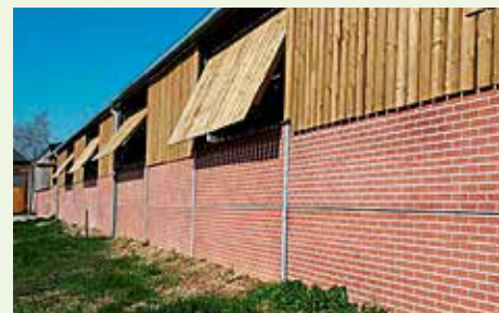
Aménagement d'un volet articulé (CA de l'Aisne)
