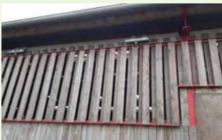
Aménagement d'un bardage ajouré coulissant (IDELE)
