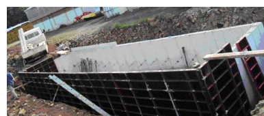
Cuve maçonnée enterrée
