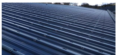
Couverture en bac acier
