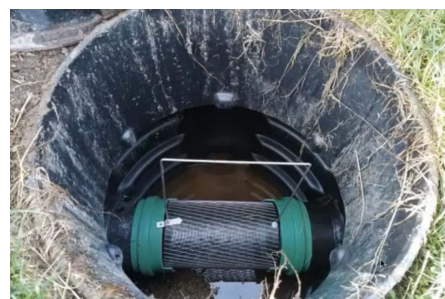
Exemple de collecteur filtrant, autonettoyant*
